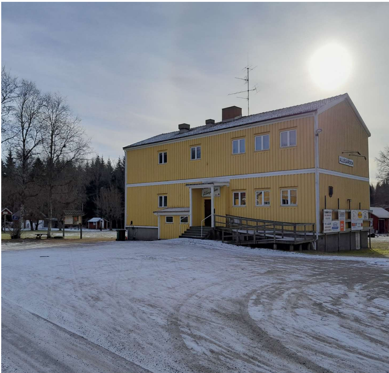
Allégården. Vänster om byggnaden ligger starten för elljusspåret
