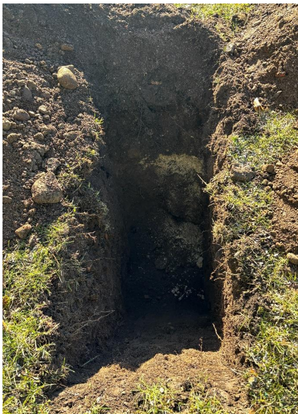
Figur 5-1. Visar ferrokalk i provgropen som rasat ner i botten av gropen (Foto: Rejlers).
