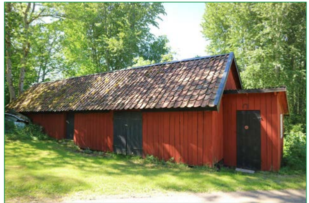
Ved- och snickarbod.
