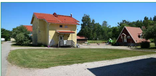
Värmecentralen till höger i bild.
