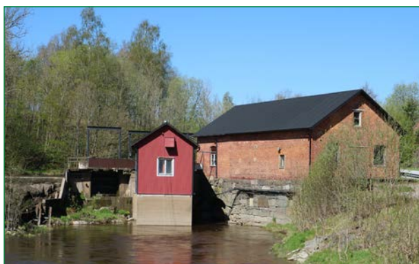
Kraftstation och kvarn på Ellenö 1:1.
