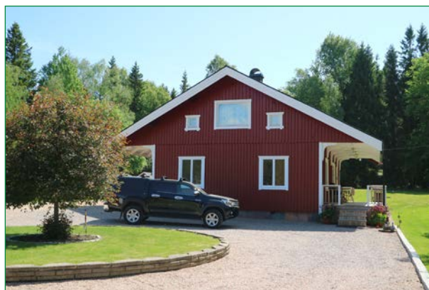
Det före detta stationshuset.
