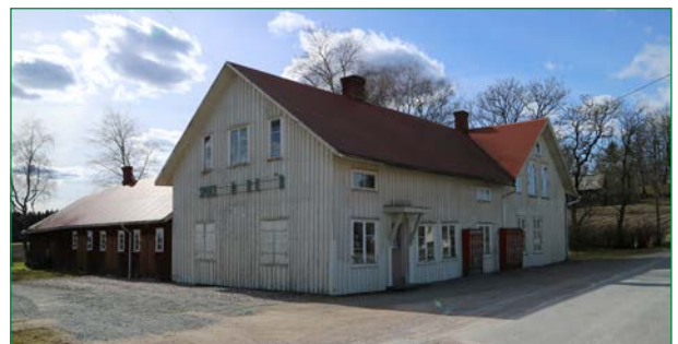
Lagerbyggnad och bostadshus.
