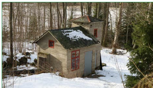
Den nedre kraftstationen.
