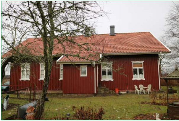
Före detta skolbyggnad, nu bostadshus.
