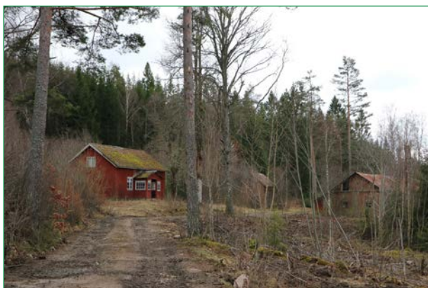
Översikt över byggnaderna.
